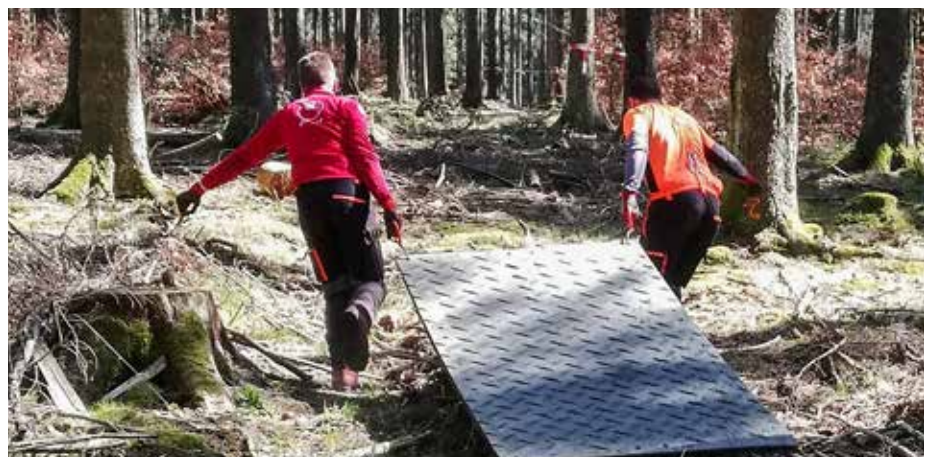
Abb. 3: Händisches Verlegen der Bodenschutzplatten
