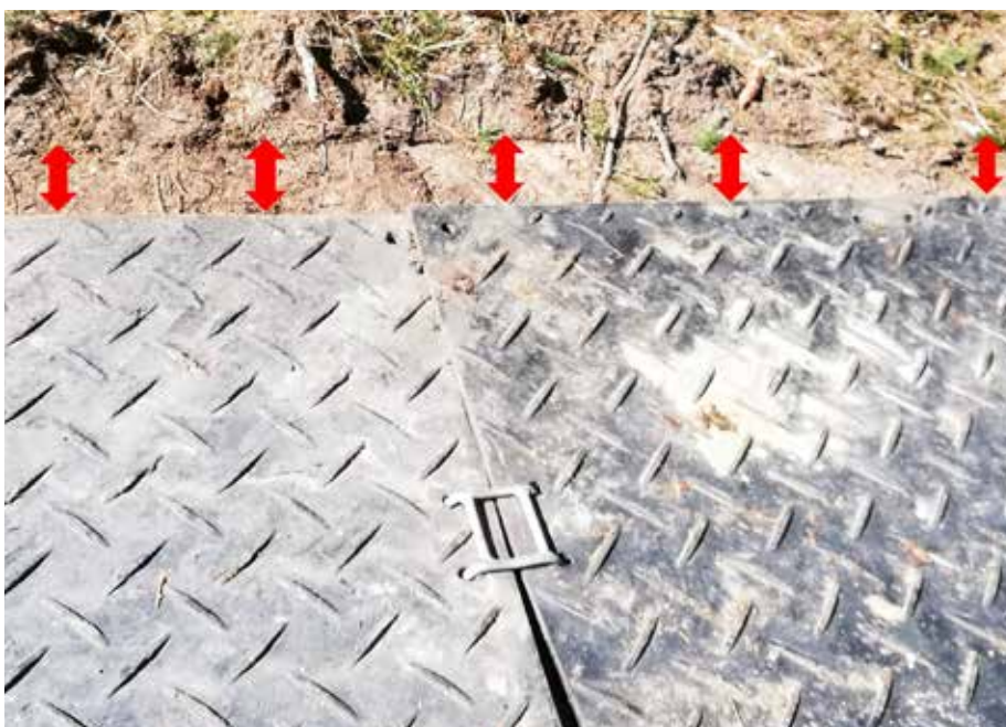
Abb. 5: Laterales Verrutschen des Bodenschutzsystems
