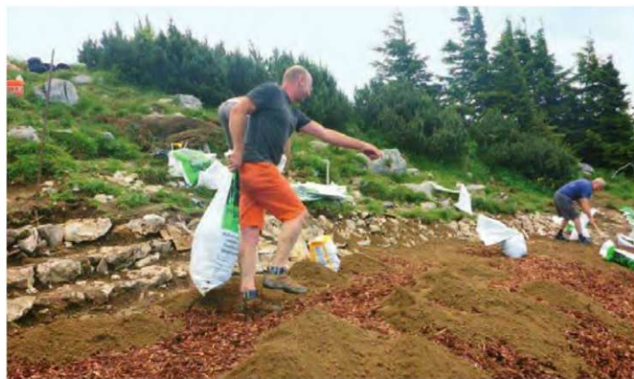
Ausbringen von Rindenmulch und Erde nach den Baggerarbeiten, um kleinere Unebenheiten auszugleichen.
