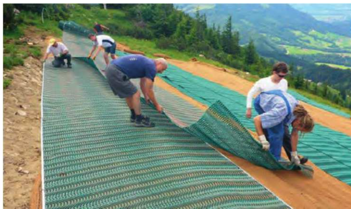
Nach nur einer halben Stunde waren die Kokosmatten ausgerollt und mit wenigen Stahlstiften vorbefestigt – (die erste Rolle Schutznetz kommt an ihren Bestimmungsort).
